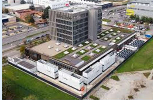
Figura 3.11. Data Center Avalon 3 di Retelit.
